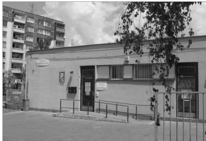
Budova Centra pro zdravotně postižené na sídlišti v Opavě 6 je bezbariérově přístupná.
