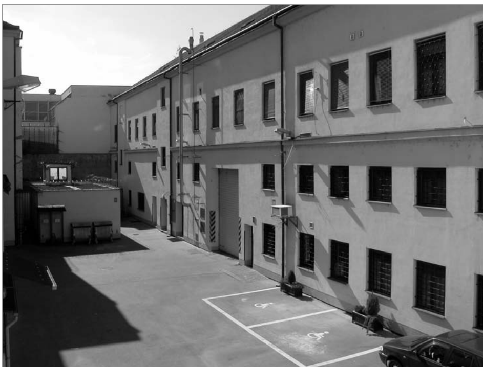
Pohled na dvůr věznice v Břeclavi, která je jednou ze čtyř s bezbariérovou úpravou. Pro případné invalidní osoby z řad návštěvníků věznice jsou vyhrazena dvě parkovací místa.
