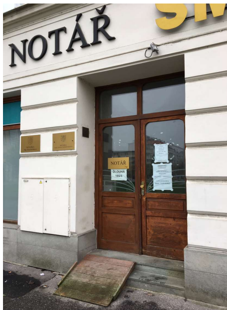
Nájezd? Ne, to určitě ne!
