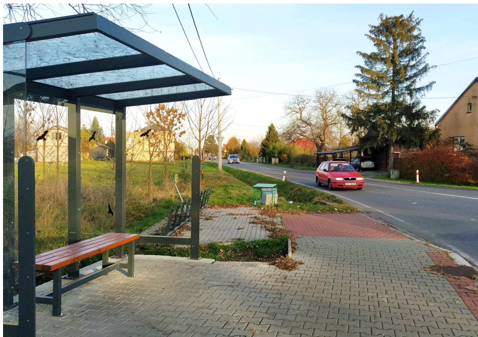
Přístupový chodník k zastávce v těsné blízkosti křižovatky ztlačně chybí
