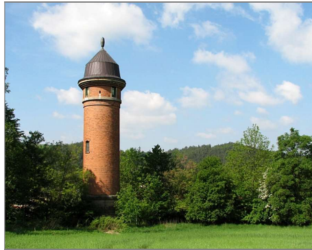
Technická památka Vodárenská věž
