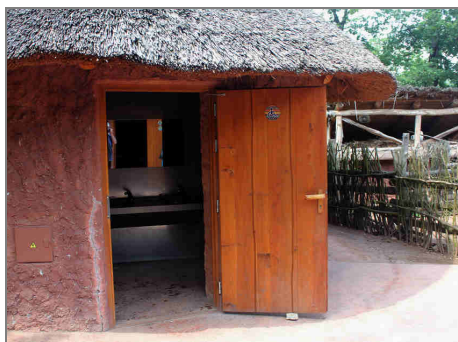
Vstup do bezbariérového WC v komplexu Kalahari brněnské zoo
