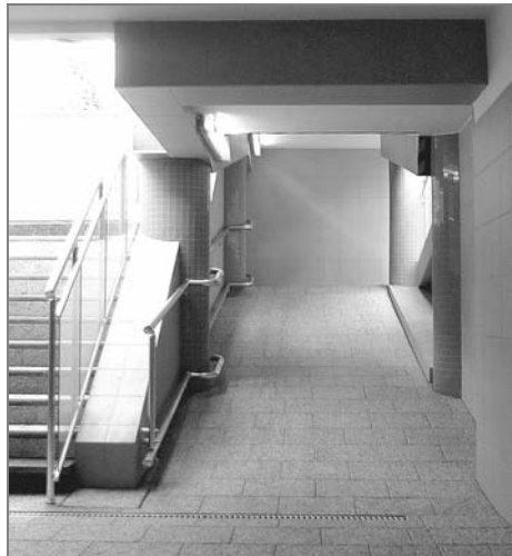
Pohled na východ z podchodu směr kostel
