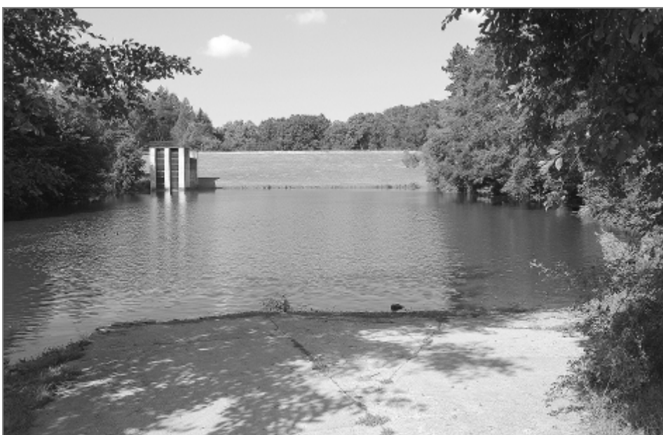
K retenční nádrži se vozičkář dostane snadno, zpevněná cesta vede až k vodě
