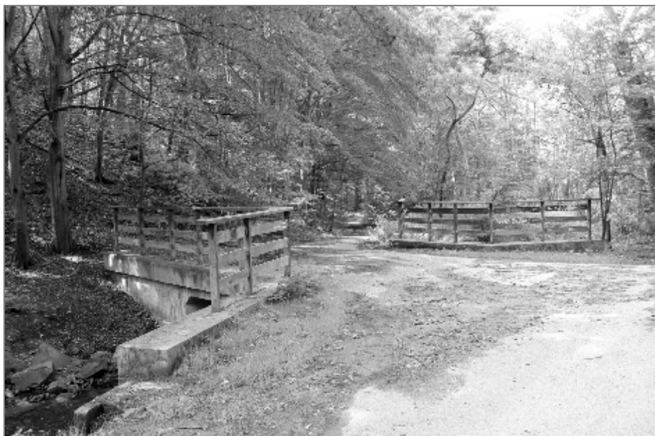
Cesta v rokli je asfaltová, můstky chráněné zábradlím
