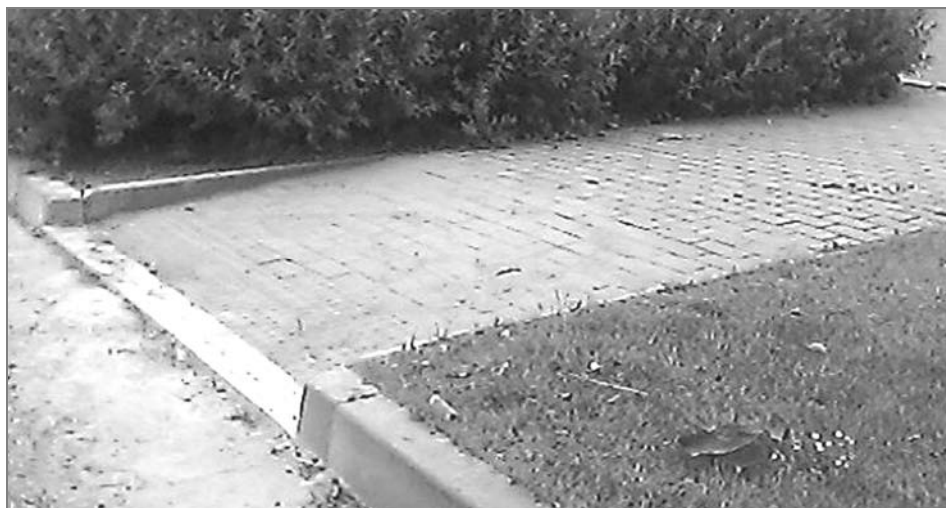
Nástupiště směr Hrabyně (Opava; Ostrava) po úpravě – nájezd I. (podobně i nájezd II.)
