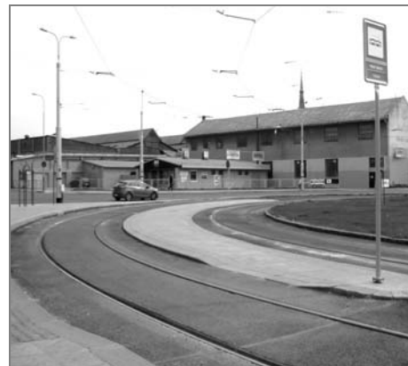
Výstup z tramvají v oblouku
