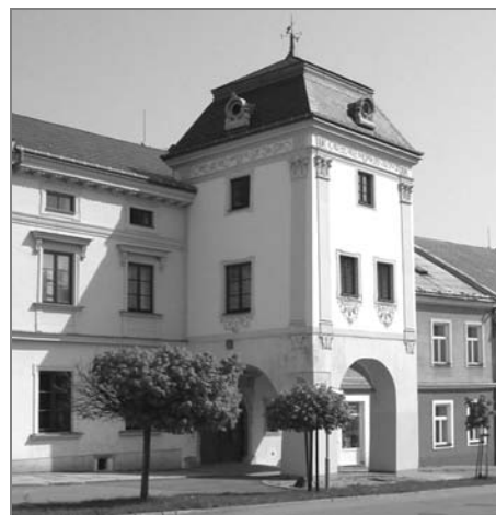
Dům Pod Podloubím v Zábřehu
