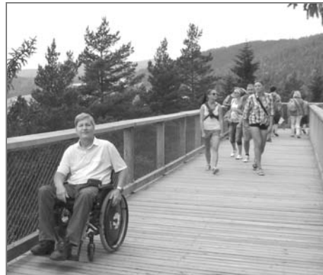
Na stezce široké 2,5 m se stoupáním 2–6 % je jízda bezproblémová. Chodník je vytvořen z fošen stejné tloušťky s minimálními mezerami. Vlně se mezi smrky na 75 podpůrných pylonech. Vršky stromů na snímku vidíte ve výšce 24 metrů!
