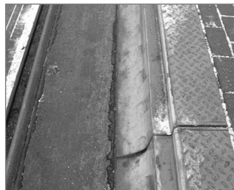
Detail Kasselského obrubníku na nástupišti Krajský úřad
