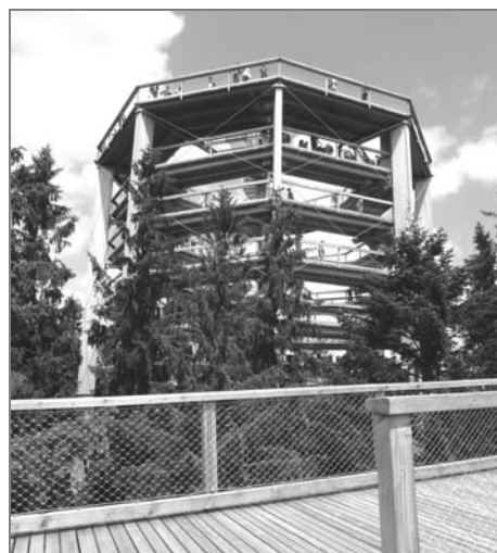
Stezka spirálovitým chodníkem navazuje na válcovitou věž o průměru 24 m až do výšky 40 m
