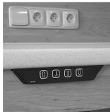
Polohování horních skříněk a pracovní desky je nezávislé pomocí dvou elektromotorů. Ovládací tlačítka jsou na panelu pod pracovní deskou.
