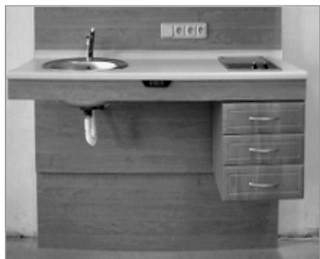
Posuvný zásuvkový kontejner lze ručně přesunovat z pozice pod varnou deskou k umyvadlu.
