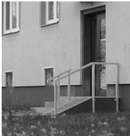
Nevyhovující zábradlí, sklon a šířka podesty.
