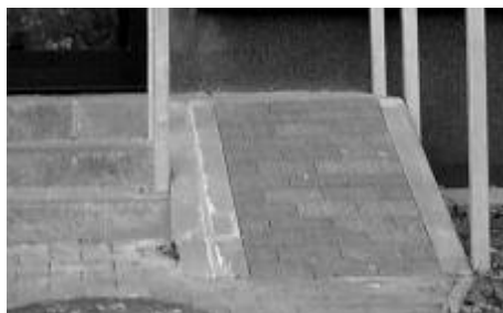
Nevyhovující zábradlí, sklon a šířka podesty.
