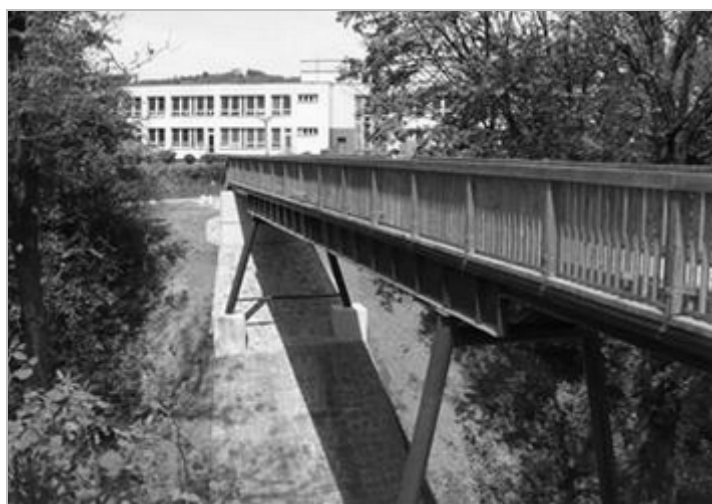
Design vč. barevného řešení lávky je zdařilý
