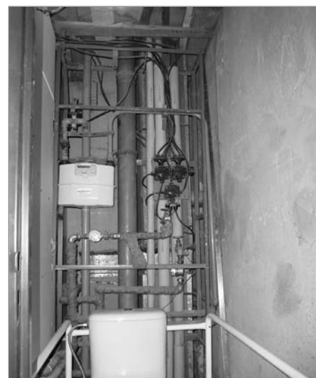
Zadní plechové kryty šachty a strop, který se opíral o pravou stěnu jádra, řemeslníci odstranili.
