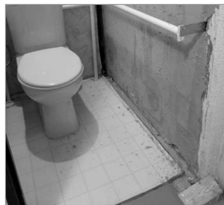
Pravou stranu místnosti po odstranění vnější stěny jádra tvoří panelová příčka.
