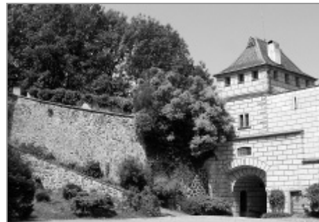
Nádvoří zámku Frýdlant zasazeného do skály.
