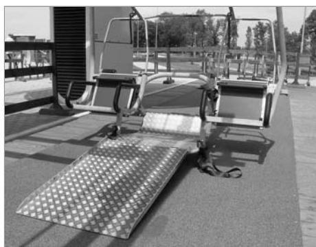
Najížděcí plošina sedačkové lanovky na Javorníku.
