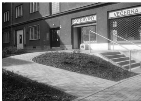
Při rekonstrukci chodníků a venkovních schodů stále slyšíme, že schody nelze
