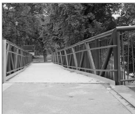
Pohled z lávky na novou rampu (vlevo kousek zábradlí stávajícího schodiště)
