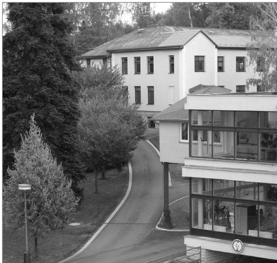
Obr. 1: Pavilóny G a D spojené nadzemní chodbou – pohled z terasy SRJ
