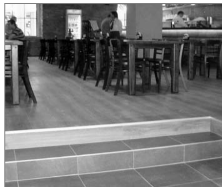
Do kavárny vstup vozíčkářům zapovězen
