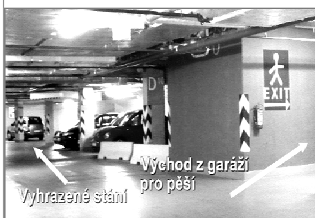
...a vyhrazené parkovací stání jsou velmi daleko od výtahů
