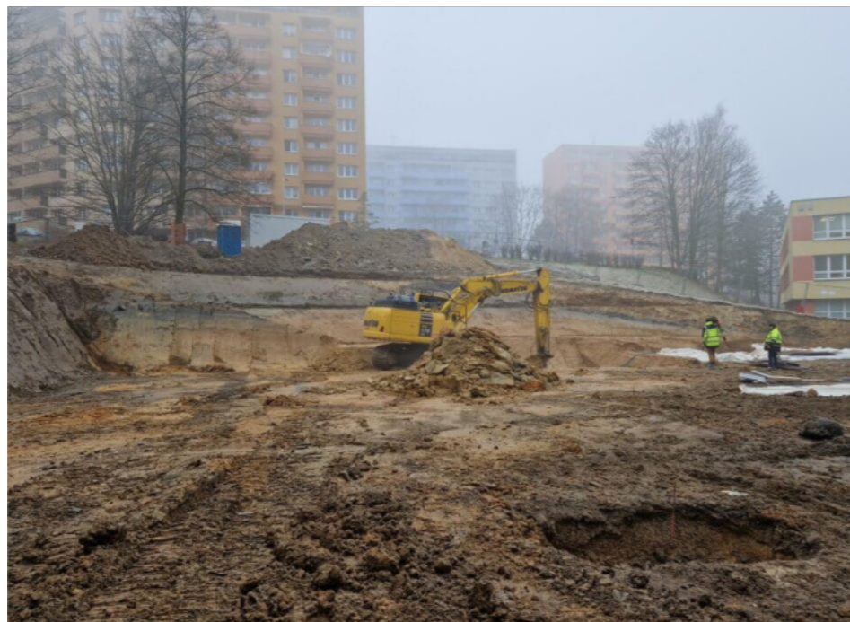
Základy nového objektu Domov MIKASA v Ostravě-Výškovicích
