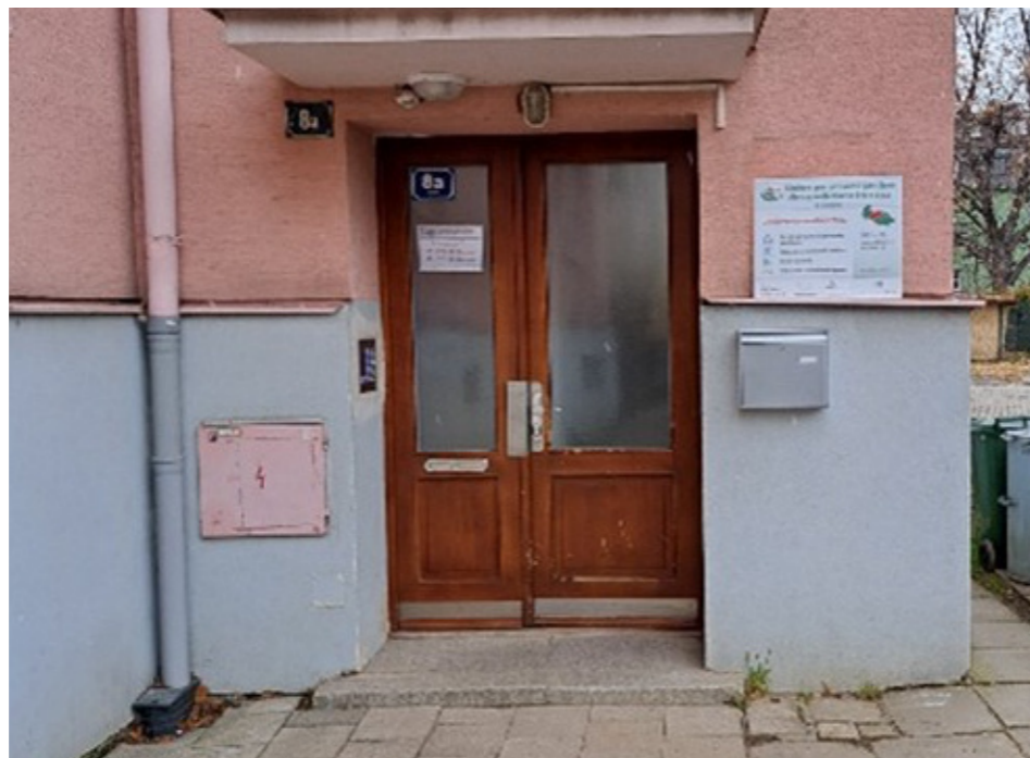
Vchod na nové pracoviště v ulici Jateční
