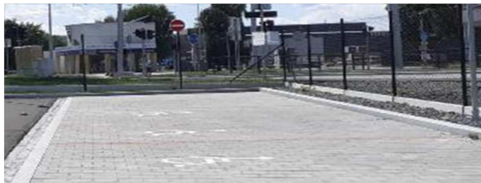
Záchytné parkoviště P + R tramvajové smyčky Hlučínská
